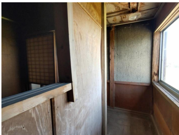
2階 階段を上がったところ
