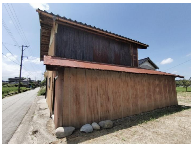
納屋外観 (北側)
