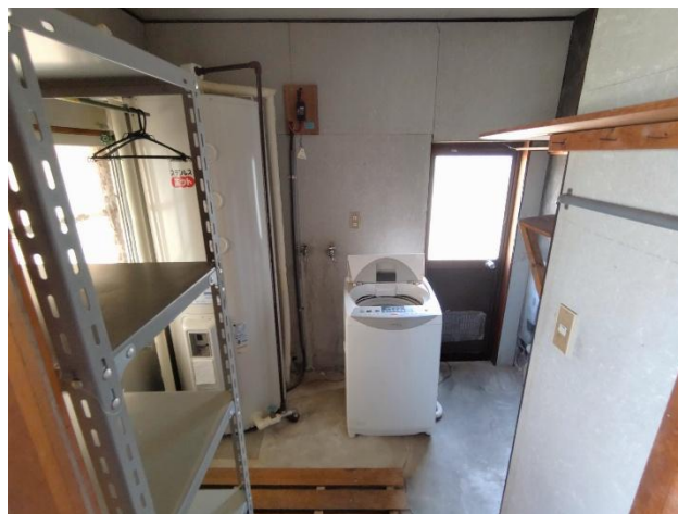
Ⅰ階 土間 A ボイラー室
