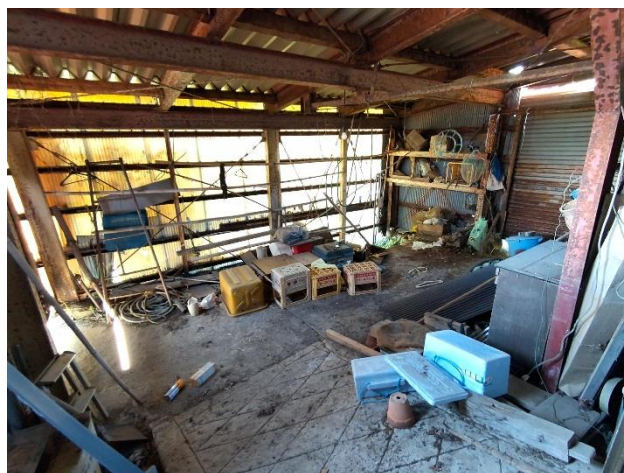
Ⅰ階 車庫B内部
