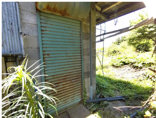
ボイラー室シャッター
