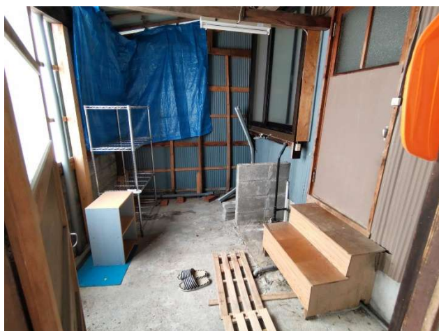
Ⅰ階 作業場
