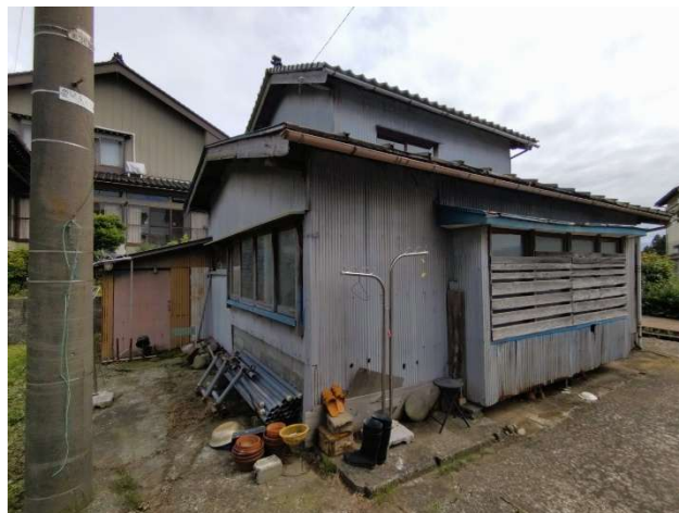
納屋外観（北側）
