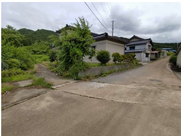
接道状況（南東向き）
