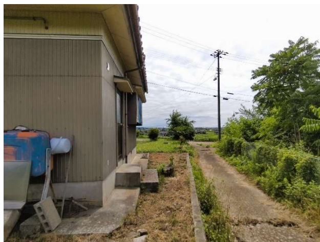
敷地境界（北西側）
