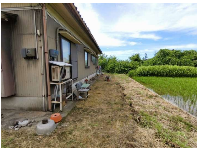
敷地裏（北東側）
