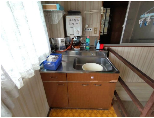
事務所2階 水場
