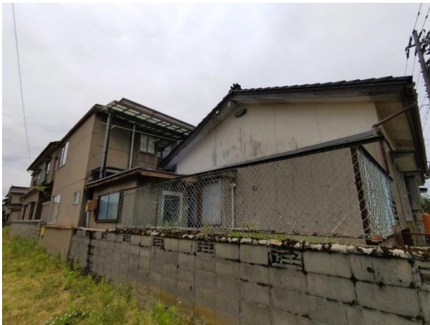
外観（東側、母屋側）
