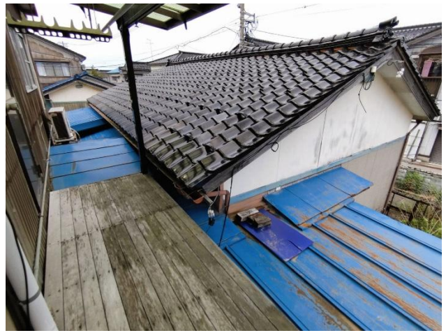
事務所2階 バルコニー
