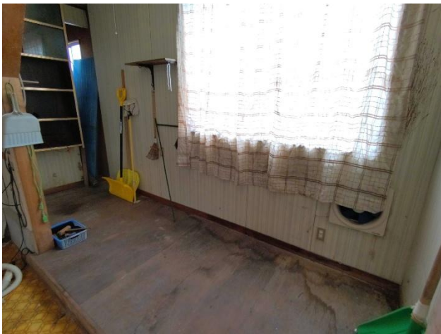
事務所 B室 板間
