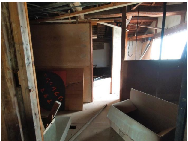
納屋上部 (別角度)
