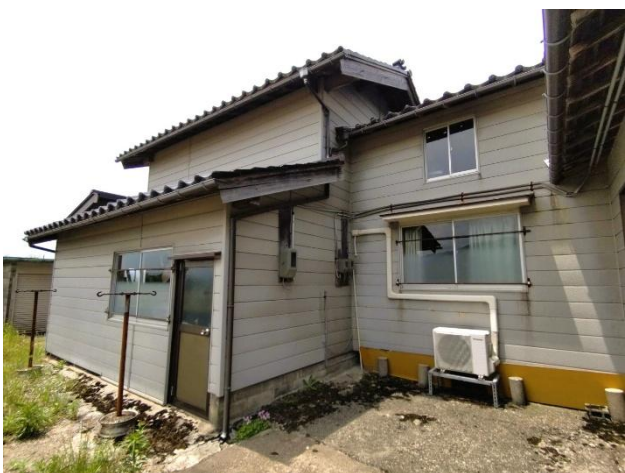
納屋・母屋接続部
