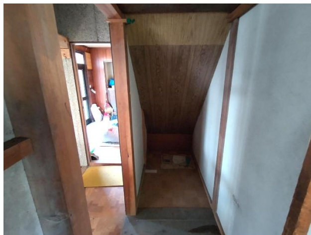
1階 階段下スペース
