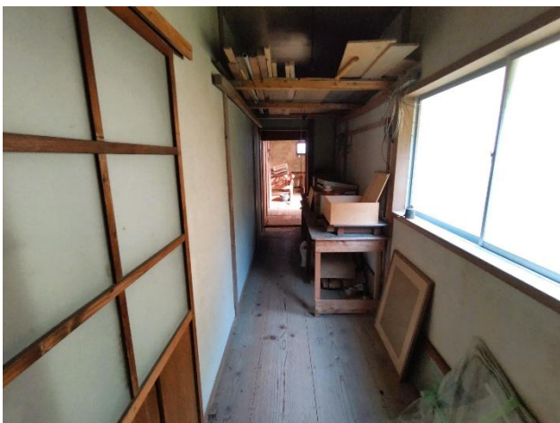
1階 廊下(納戸側)
