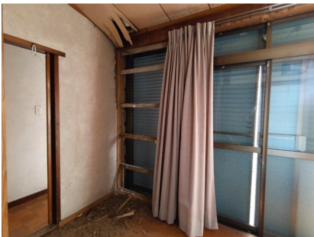
1階 広縁 窓、天井
