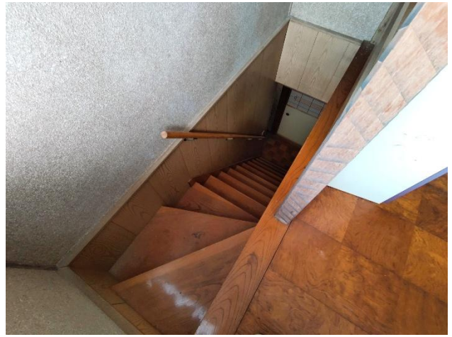
2階 見下ろした階段
