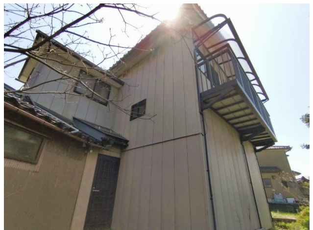
外観（西側、増築側）
