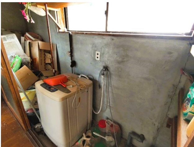
1階 洗濯機置き場
