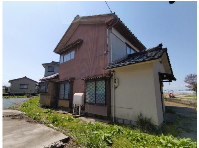
外観（東側、玄関側）
