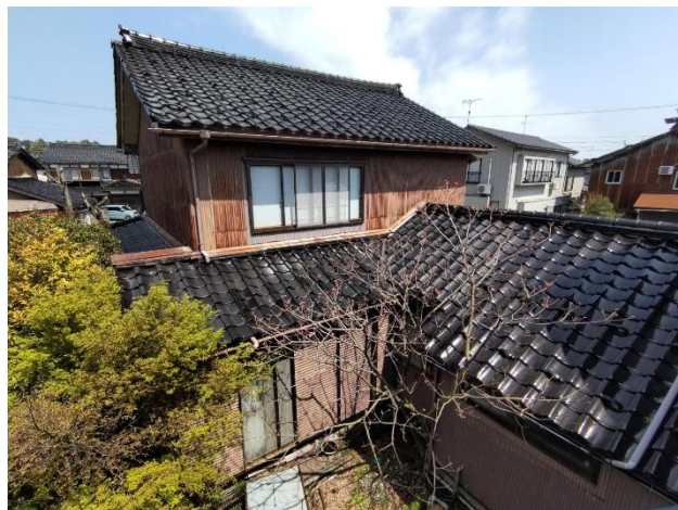
2階 ベランダから見た外観
