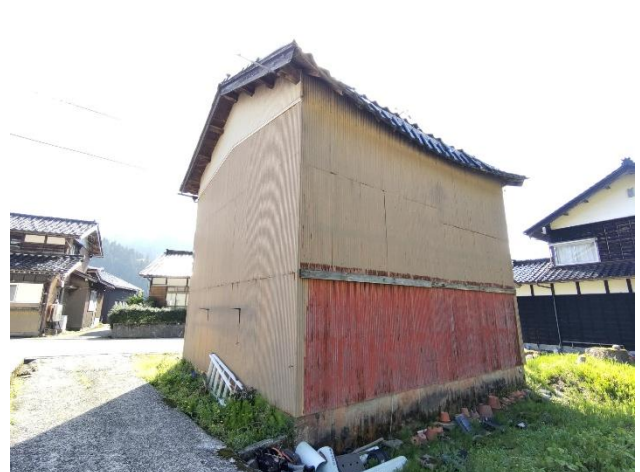
納屋外観（北側）
