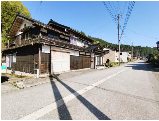
接道状況（南東向き）
