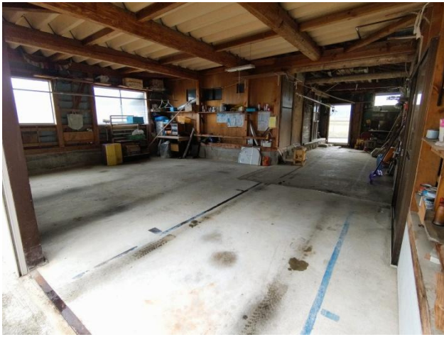
車庫兼納屋 車庫部
