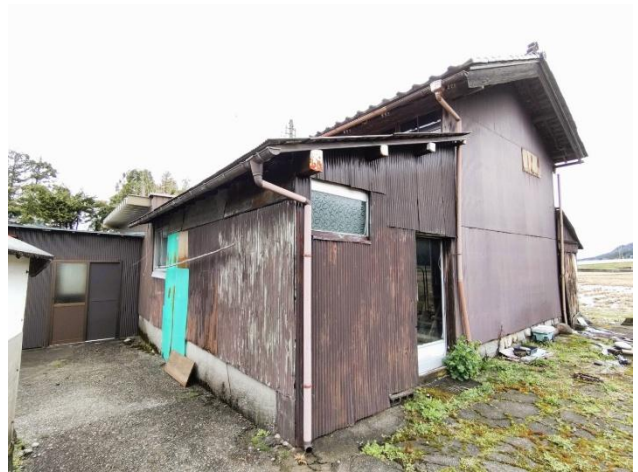
車庫兼納屋外観（東側）
