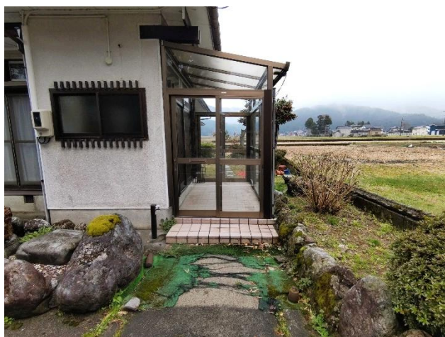
玄関前アプローチ
