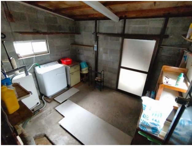
1階 ボイラー室
