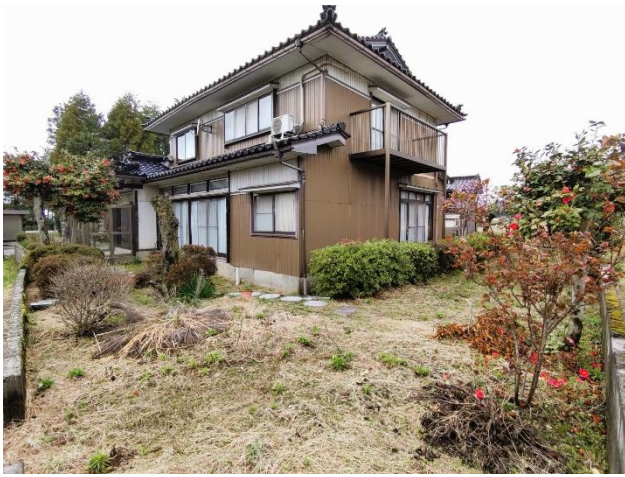
母屋外観（南側・東側）、庭
