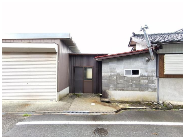
外観 (西側、車庫兼納屋・ボイラー室側)
