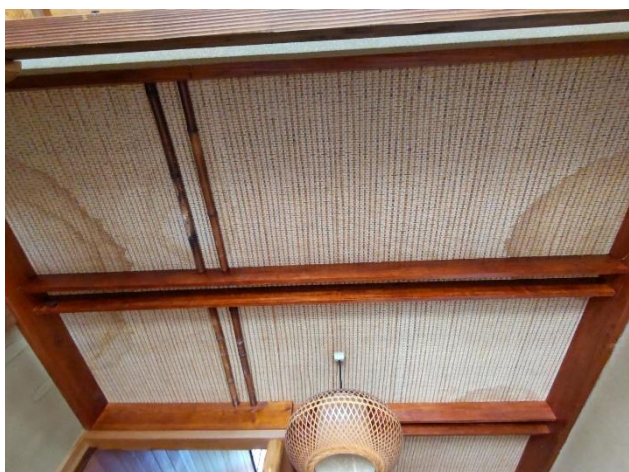
Ⅰ階 廊下 天井染み
