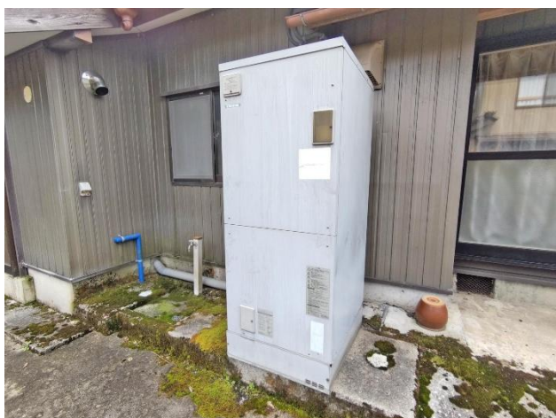
電気温水器 ※故障中
