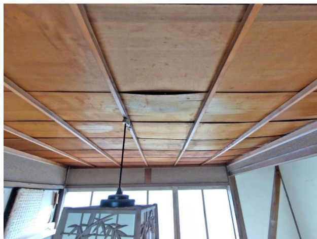
2階 和室6帖E 天井
