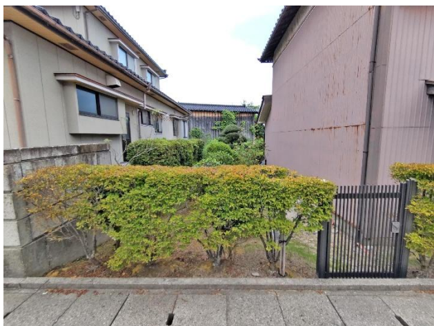
外観（南側、庭入口）
