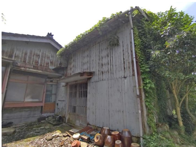
母屋・納屋 A 外観（接続部）
