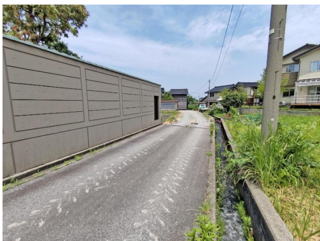
接道状況（北向き、敷地前道路）
