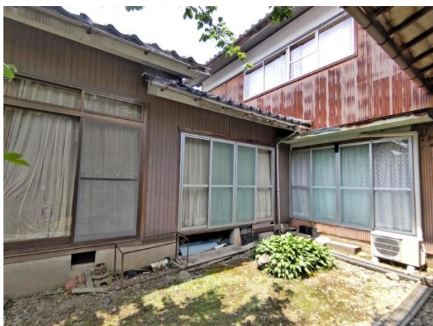
母屋外観（増築接続部）
