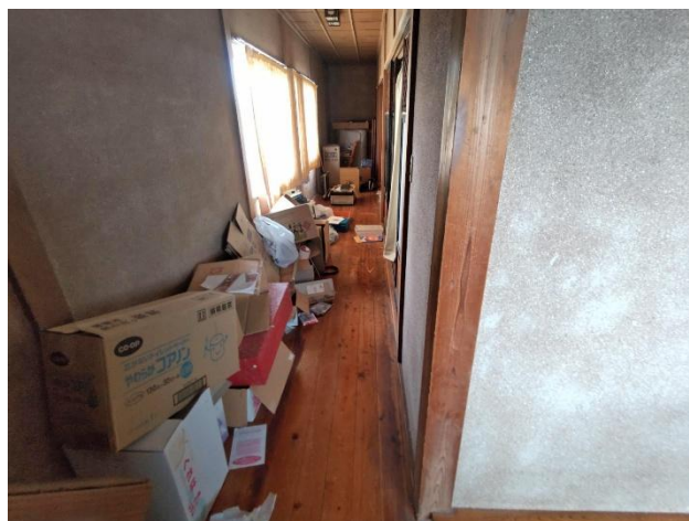
2階 廊下（西向き）
