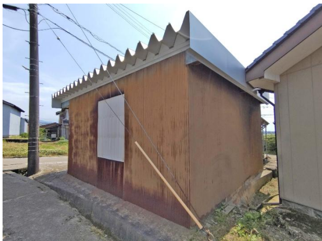
車庫外観（東側）
