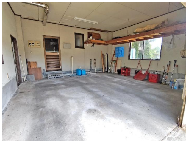
車庫内部（屋外側から）
