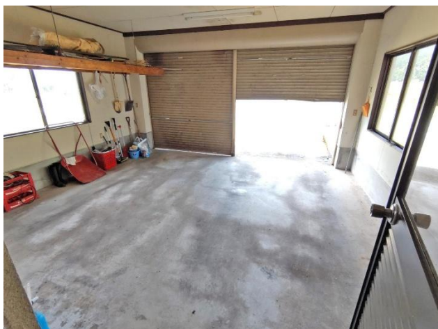
車庫内部（ボイラー室側から）
