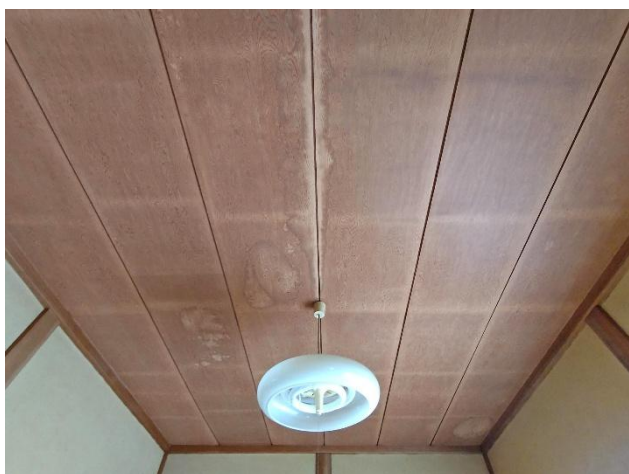
2階 和室6帖C天井
