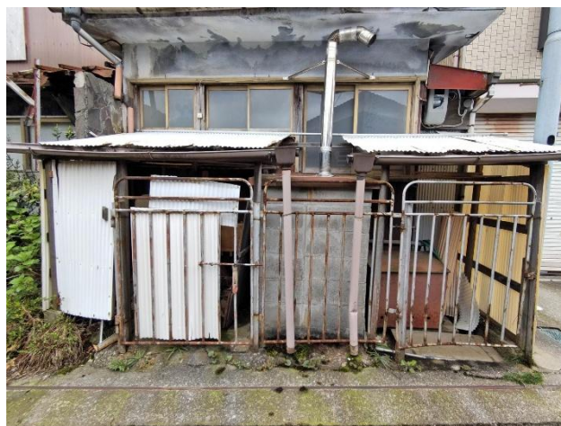
外観 設備小屋 (北側)
