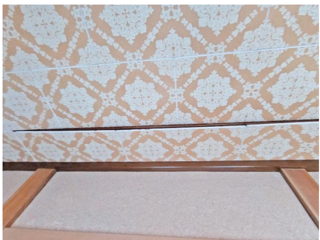
2階 縁側 A 天井
