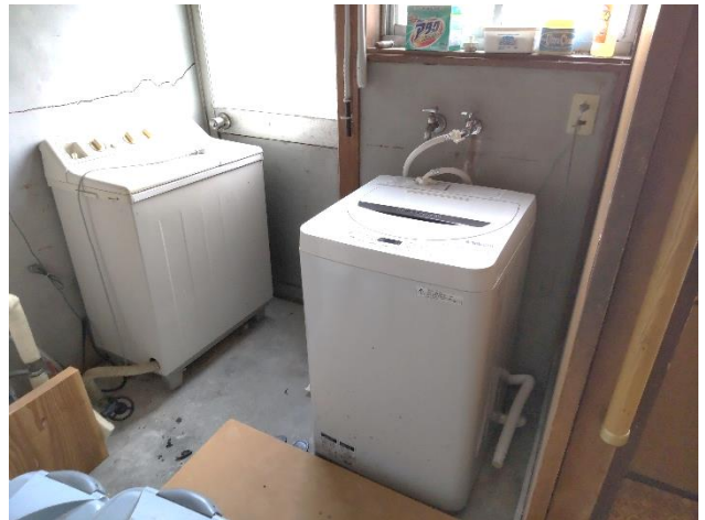
1階 洗濯機置き場・ボイラー置き場
