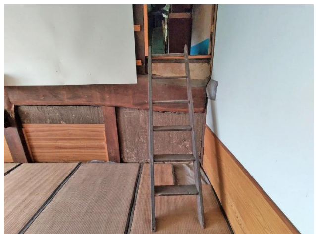
2階 和室12帖 納戸A入口
