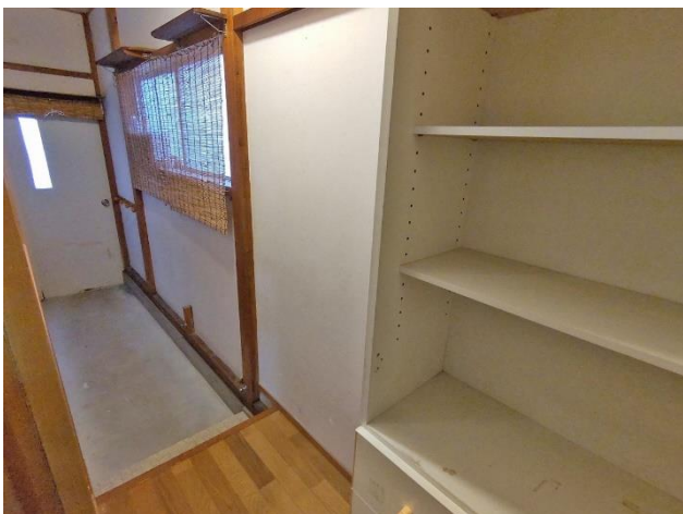
1階 勝手口通路
