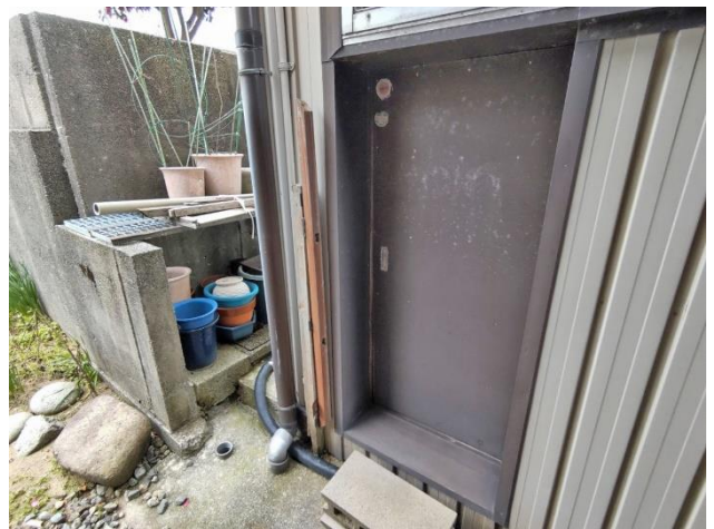
ボイラー室 裏口
