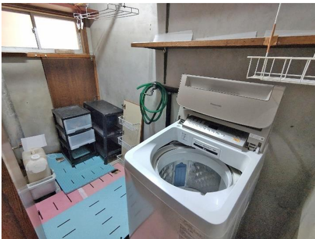
1階 洗濯機置き場、ボイラー室
