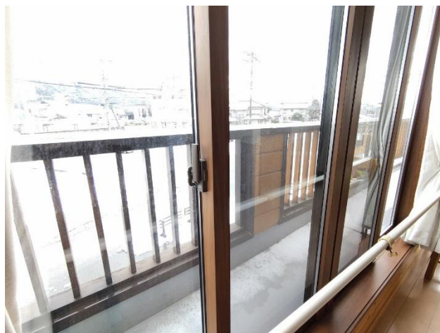
2階 洋室10帖バルコニー（東側）
