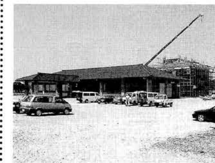
建設が進む朝日浄化センター
