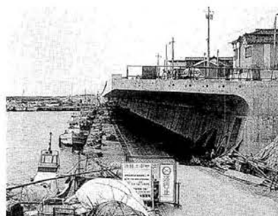
工事が進む漁港道路
