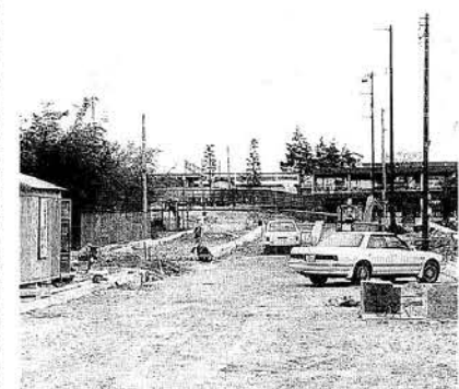
工事が進む泊駅前・町道停車場東草野線
