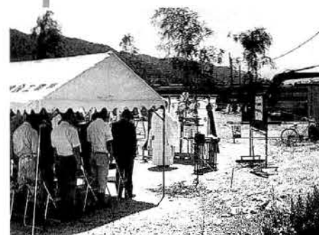
▲残り区間の工事の安全を祈願
