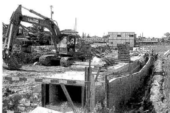
▲中の川用水路付け換え工事
