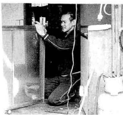
▲壊れた戸を修理する組合員
