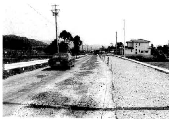
▲建設が進む、泊桜町線立体交差点部
