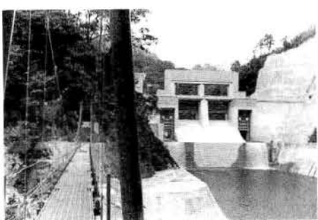
▲完成となった北又ダムとつり橋
