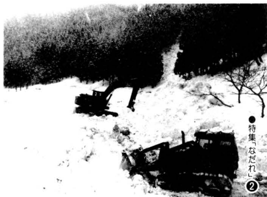
今年の2月15日、大平地内で発生した雪崩で埋まった県道を復旧する除雪車
