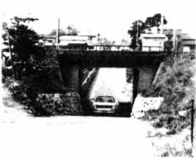
▲改良が待たれる国鉄立体交差部
