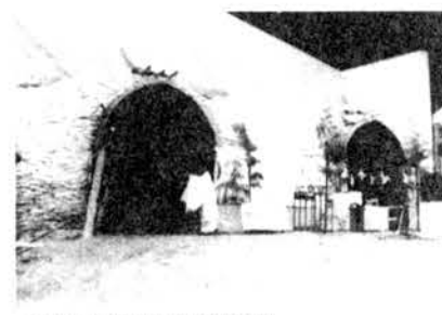
▲笹川側 側壁導坑部
