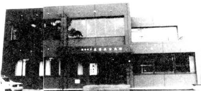
▼完成した五箇庄公民館
