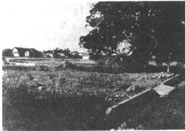
<工事中の舟川新農村公園>
