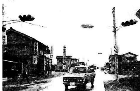
(写真は横尾地内に設置された信号機)
