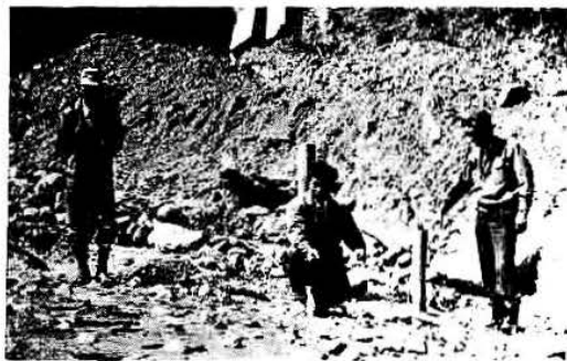
＝崩壊現場に張られたインバー線＝
