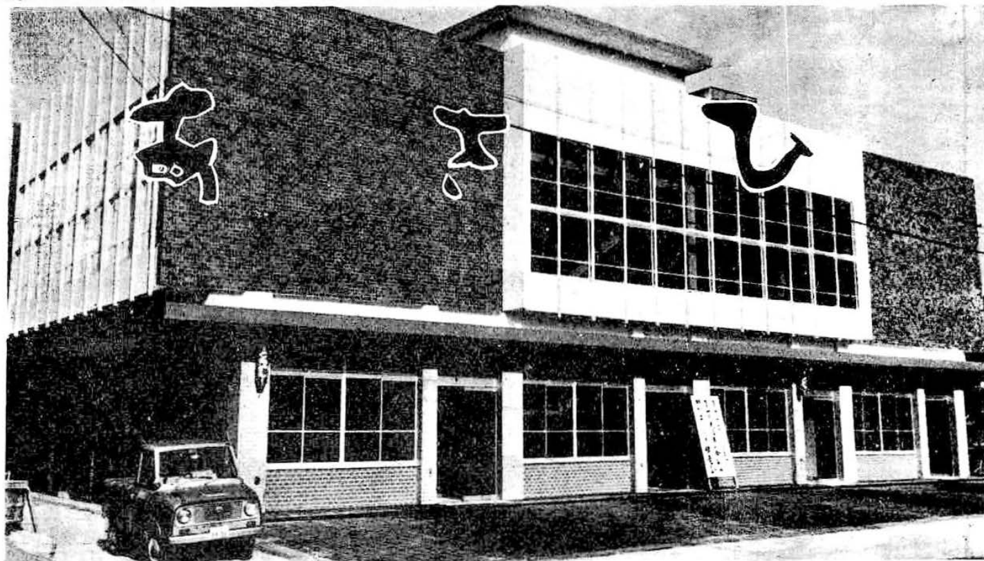
新築なった南保公民館
