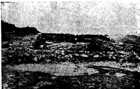
<写真＝全壊した朝日小屋>
