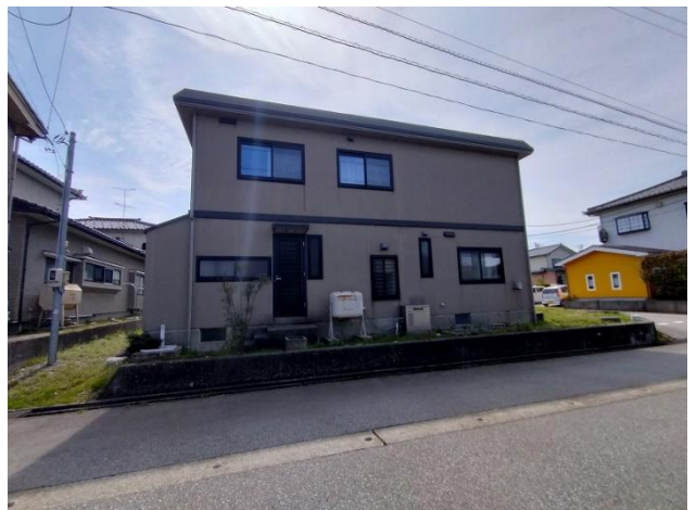
外観 (南東方向に撮影)
