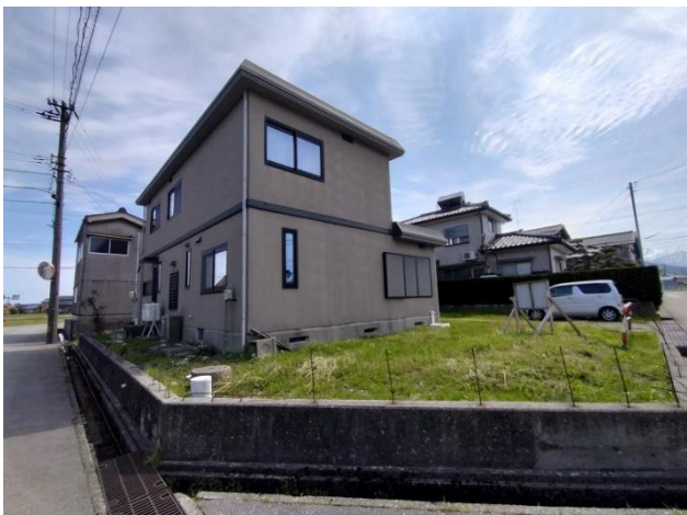
外観 (東方向に撮影)
