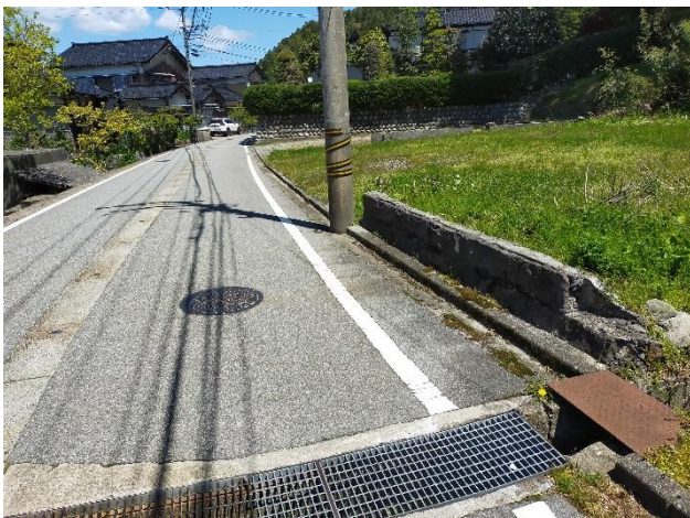
接道状況（北東方向）
