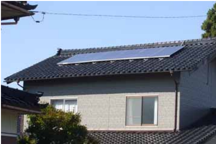
町の補助制度を活用し太陽光発電システムを設置している住宅
