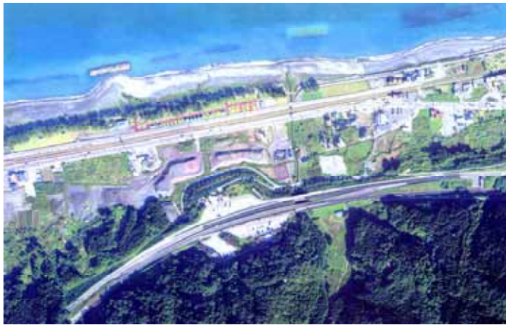
パークゴルフ場等の整備予定地（北陸自動車道と国道8号に囲まれたエリア）
