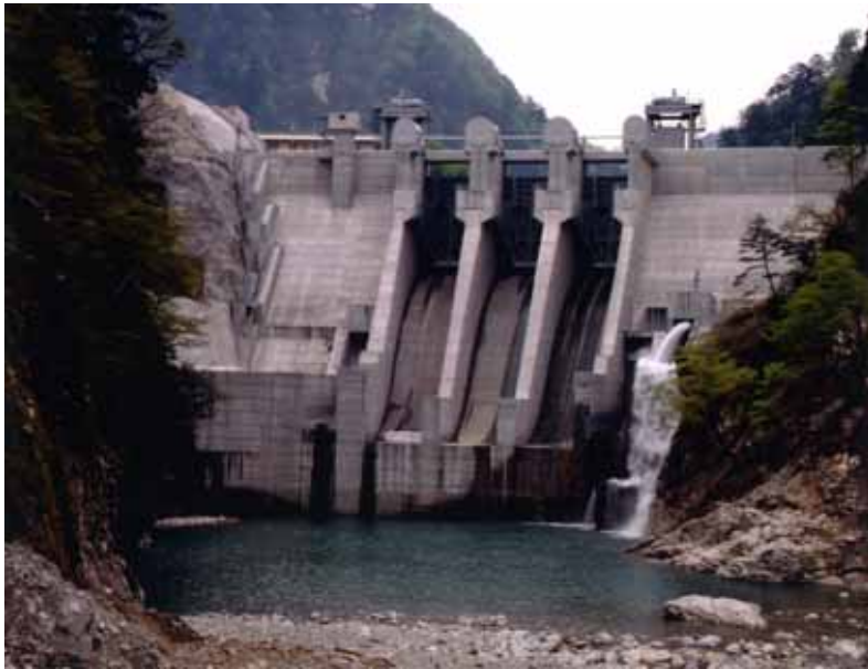
黒部川上流にある出し平ダム
