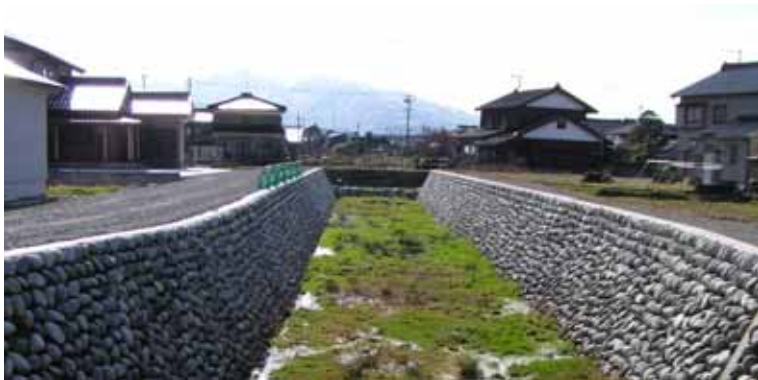
中断している二級河川寺川工事
