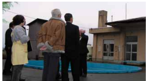
山崎保育所の屋根の状況を確認する民生教育委員会
