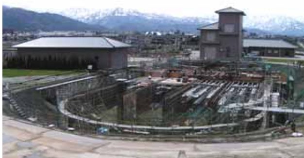
朝日浄化センターの汚水処理施設増設工事
