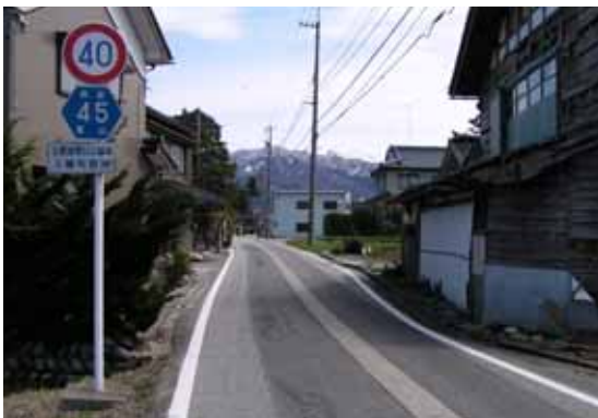
入善町野中地内の未整備区間
