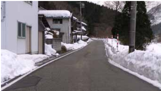
未整備区間の県道山崎泊線
