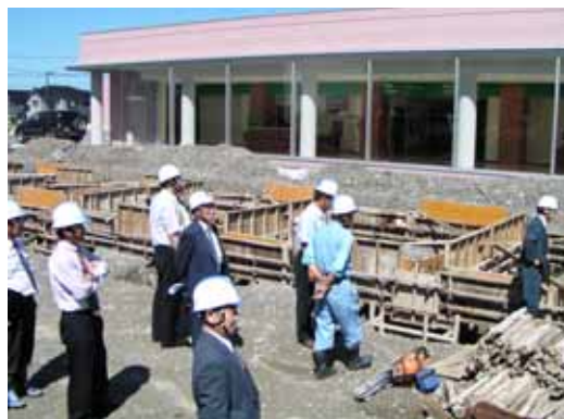
あさひ総合病院正面玄関前回廊工事現場
