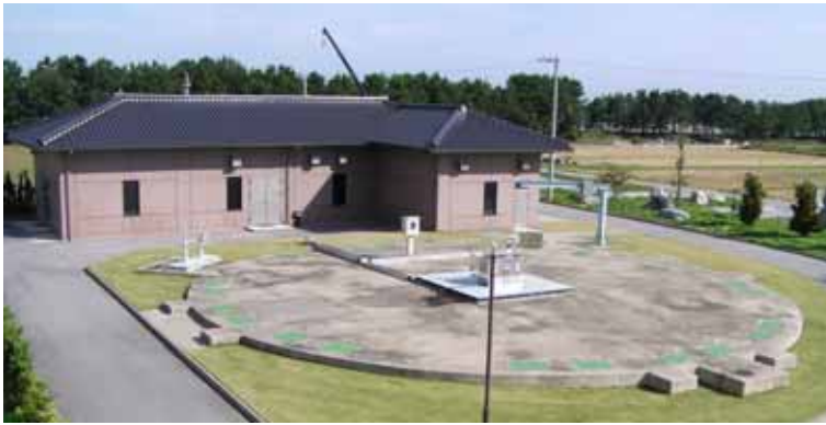
増設される水処理施設
