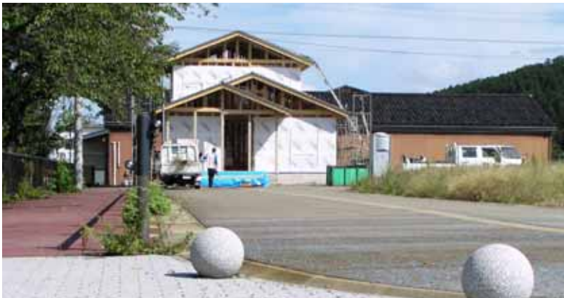
よこお団地に新築中の住宅
