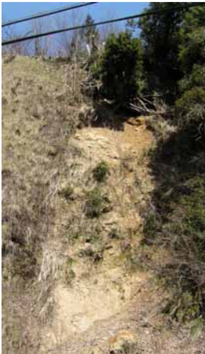
蛭谷地内の山腹崩壊箇所
