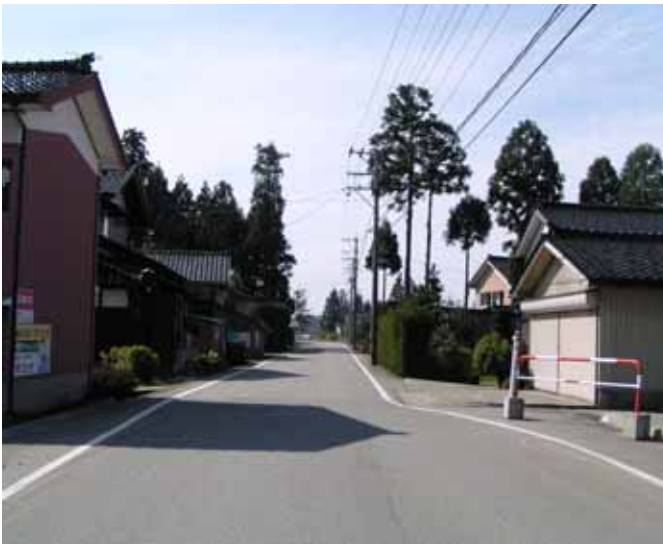
細野地内の未整備区間
