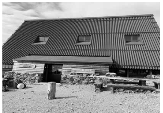
改築修繕があった朝日小屋
