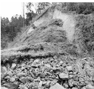
台風19号により土砂で 埋まった林道
