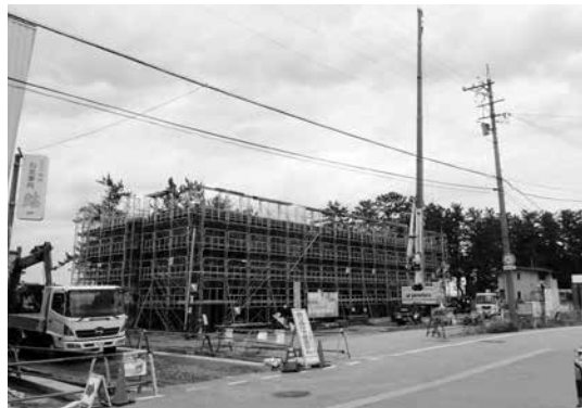
ヒスイ海岸観光交流施設工事現場
