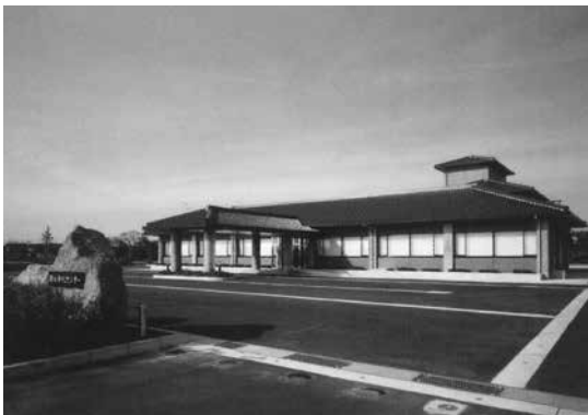
朝日浄化センター
